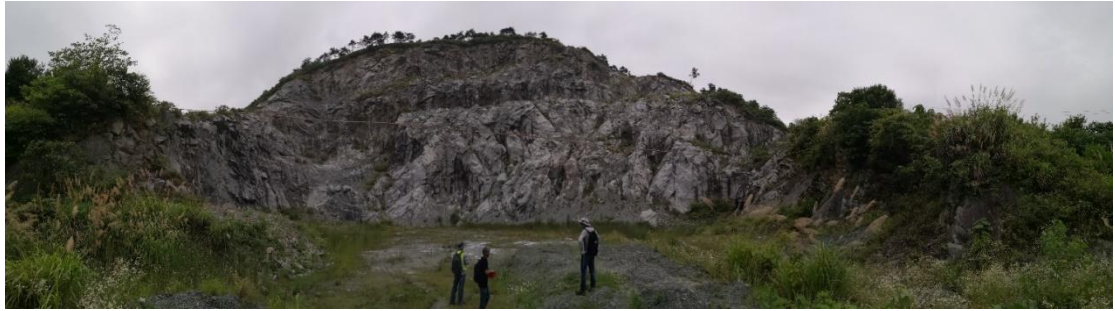
（ 图 2：北矿坑现状 ）
