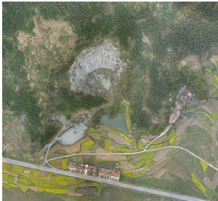
（ 图 1： 矿区航拍图 ）
