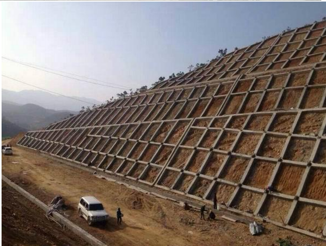
（图：锚杆（锚索）格梁加固法示意图）
