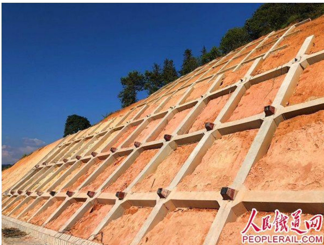
（图：锚杆（锚索）格梁加固法示意图）
